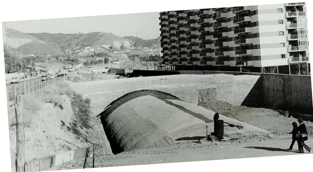
Obres de prolongació de la línia 3 del metro des de Lesseps fins a Vall d'Hebron, 1976. Foto: Brangulí. Arxiu Nacional de Catalunya
